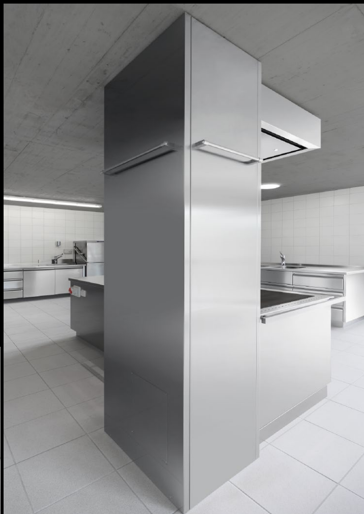
Säule komplett in Edelstahl verkleidet
